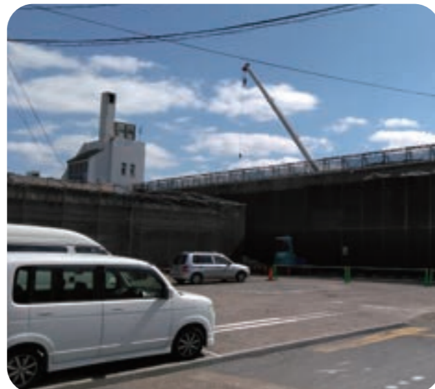
高槻荘大規模改修工事着工
